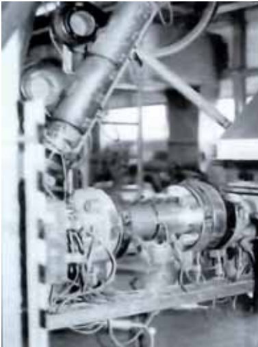
Rys. 6 Dodatkowa strefa układu uplastyczniającego wytłaczarki
