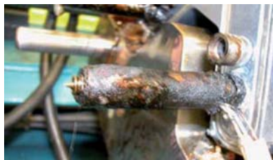
Rys. 9. Zalenie systemu tworzywem spowodowane uszkodzeniem uszczelnienia (styk tulejki centrującej z komorą) w obszarze przewężki dla dyszy Typ 2.
